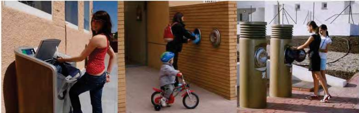
Puntos de vertido, de izquierda a derecha, buzón tipo NOA, compuerta y buzón FS, en Madrid. Barcelona y en la urbanización de El Toyo Almería.
