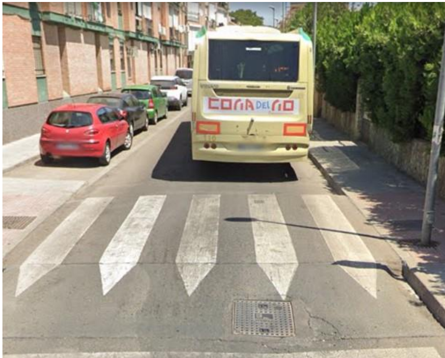
Imagen 2. Paso de peatones elevado con badén en Avda. de la Libertad. Aceras laterales y banda de aparcamiento.
