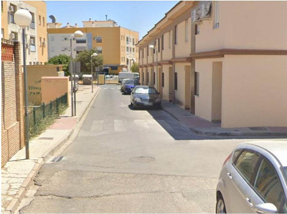
Imagen 13. C/ San Ildefonso. Cambio de asfalto, línea de aglomerado.
