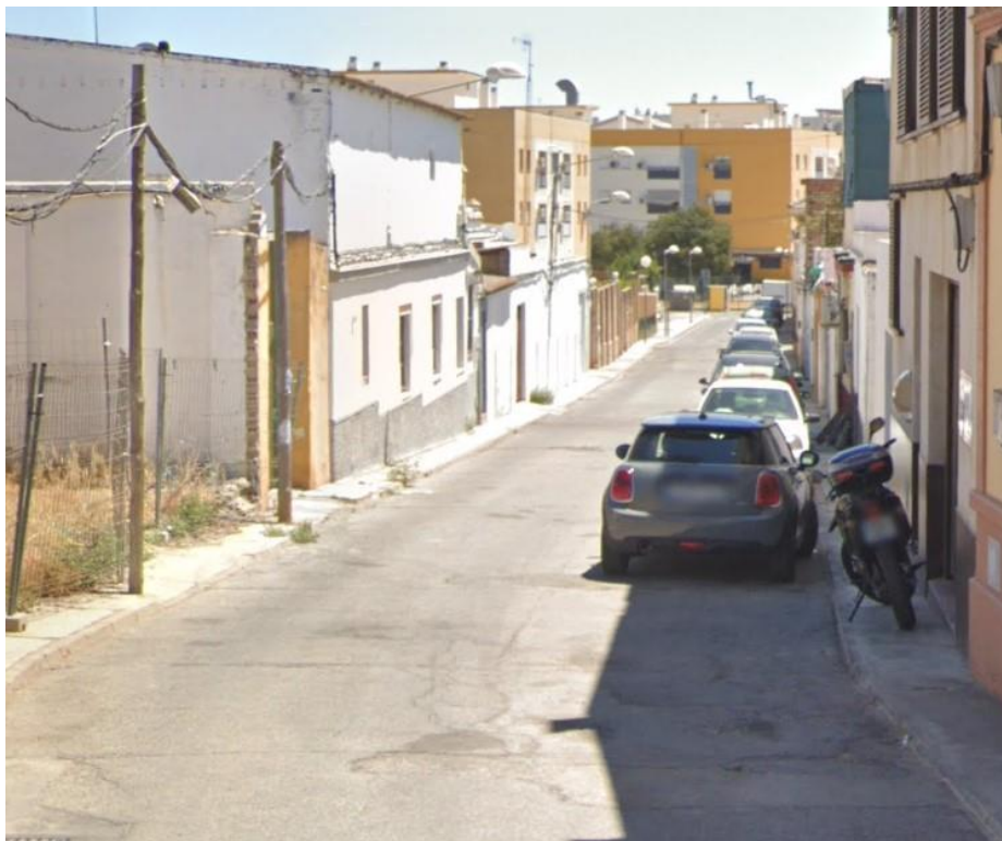
Imagen 12. C/ San Ildefonso. Pavimentos en mal estado.
