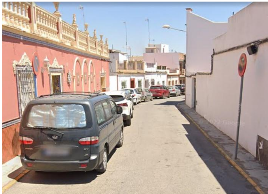
Imagen 8. C/ Dolores Solano. Acerado lateral en muy mal estado.
