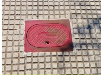
Arriba: Riego automático público arbolado. Arriba, derecha, zona empleada para venta de viviendas de anterior promoción. Abajo: registros de Agua e Hidrante de incendios
